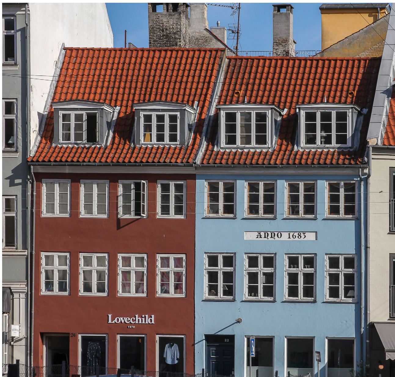
Fig. 12. I St. Regnegade ligger nogle af det gamle Københavns ældste beboelsesejendomme, der har overlevet brandene i både 1728 og 1795.
