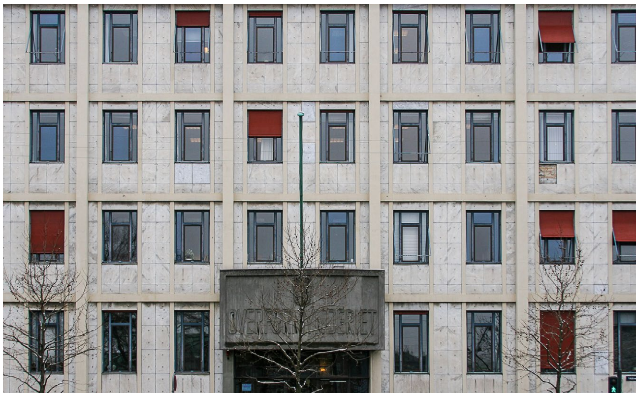
Fig. 24. Overformynderiets bygning før renovering. Bemærk facadebeklædning af grønlandsk marmor.
