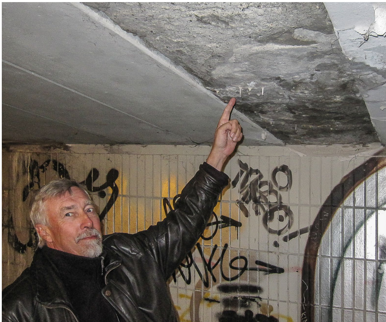
Fig. 4. Drypsten (concrethemmer) i tunnelen under Sølvgade.
