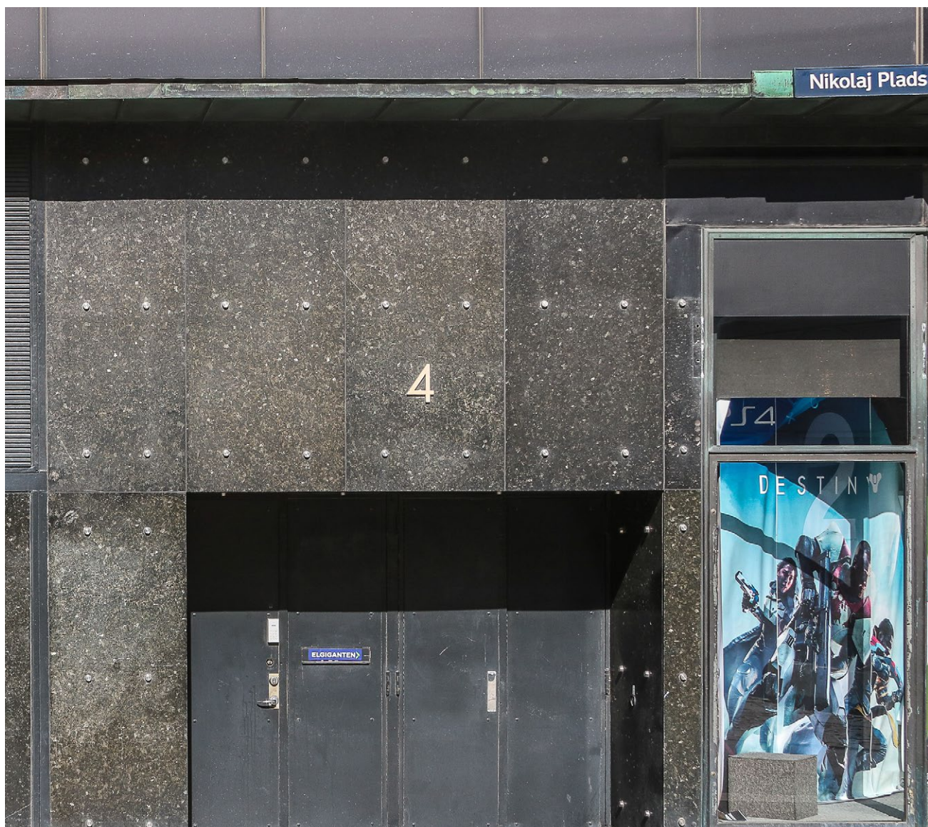
Fig. 16. Facaden af Solvåg peridotit på Nasdaqs bygning ved Elgiganten i Østergade 47.
