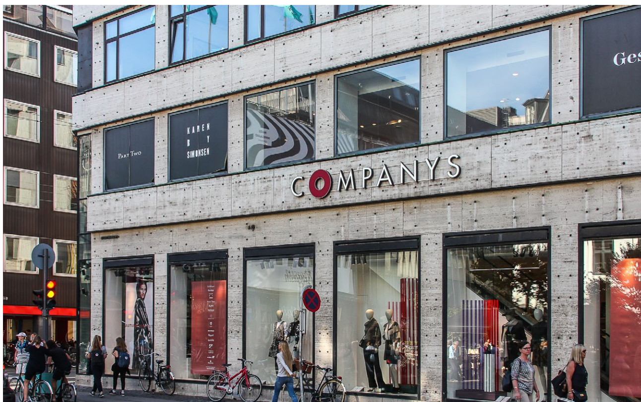
Fig. 15. Travertinfacade på hjørneejendommen Østergade 27. Bemærk lagstrukturene, der viser op/ned på stenene.
