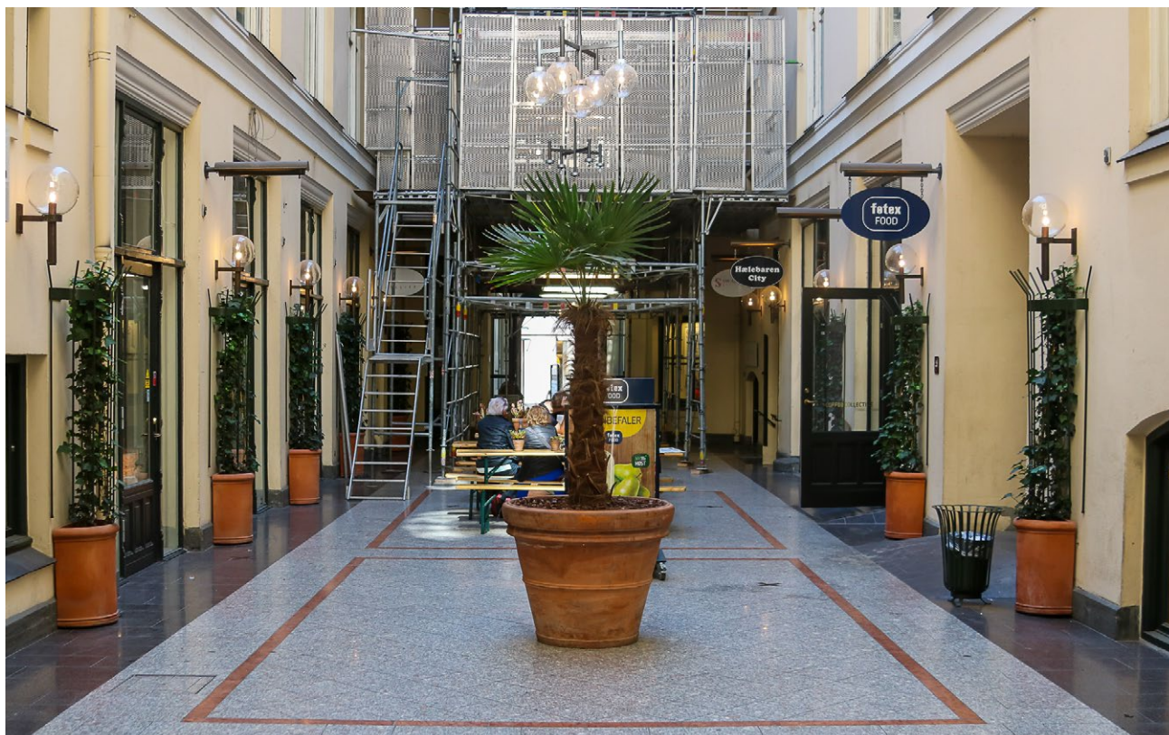
Fig. 13. Gulvfliser i Kr. Bernikows Gård udført i sardinsk granit med store feldspatkrystaller. Det røde bånd er Rosso ammonitico marmor fra Italien.
