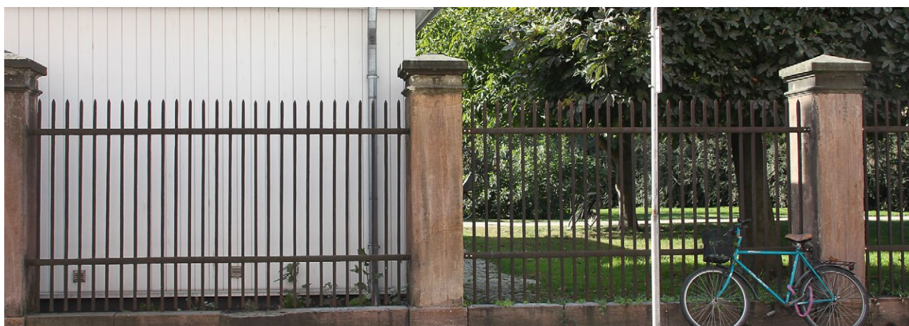
Fig. 9. Gittersøjler ved Kongens Have udført i Nexø sandsten med tydelige forsæt strukturer, der viser op/ned i stenen. Alle søjler er roteret 90 grader i forhold til original lagdeling.
