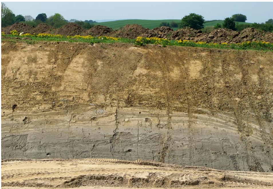
Fig. 7. Skalførende silt med spredte, håndstore sten. I et område umiddelbart til højre for fotoet er der ved gravearbejdet fundet flere 0,25 m 3 store sten. Den siltrige aflejrung er med et stort vandindhold meget ustabil. Fotoet viser en diapir, der er trængt frem i vandret retning. Toppen af diapiren er på en kort strækning blevet noget eroderet (se også Fig. 8). Over erosionsgrænsen er der sket fortsat sedimentation. Ændringen i farven skyldes oxidation på grund af, at sedimenterne er mere sandede og derfor mere permeable. Profilet er 9,5 meter højt og er beliggende i område 9. Nord er til højre i fotoet.
