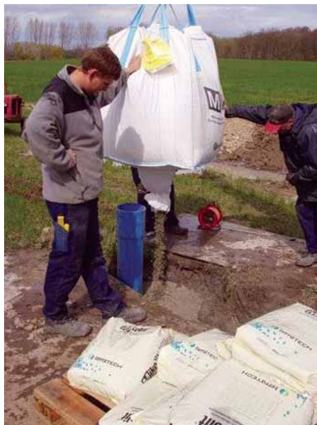
Boringsudbygning. Her forsegles med bentonit.
