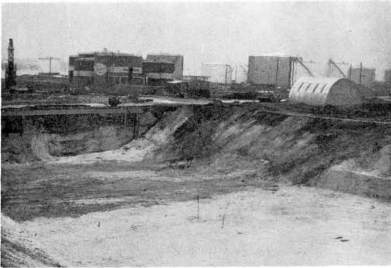
Fig. 2. Limfjordstunnelen. Dal i kridtoverfladen i østvæggen af søndre nedkørselsrampe. Dalen er fyldt med kvartære aflejringer, hvis mørke farver markerer dens forløb over udgravningens kridtbund.
