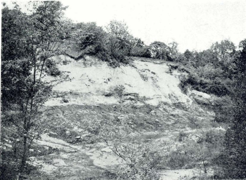
Fig. 5. Skredet ved Klarfald. I væggen ses øverst sand og derunder brunkul og sort ler. Grundvandet pibler ud fra leret og bobler op fra dalbunden foran skredprofilet. 22. maj 1956.
