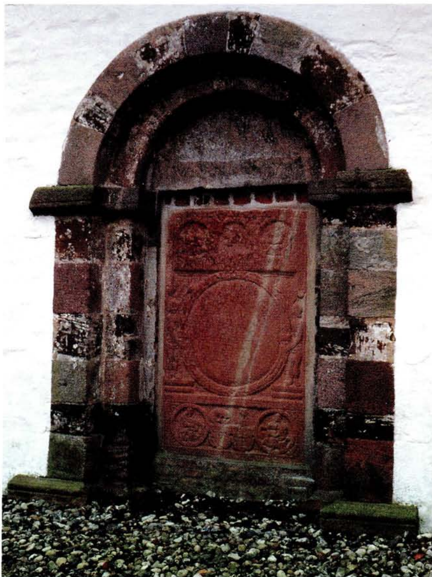
Fig. 10. Vejerslev kirke. Hovlbjerg herred. Blokke af myremalm skifter med marksten i norddørens indfatning. Døren er i sen tid blevet tilmuret med en barok gravsten. November 1990.
