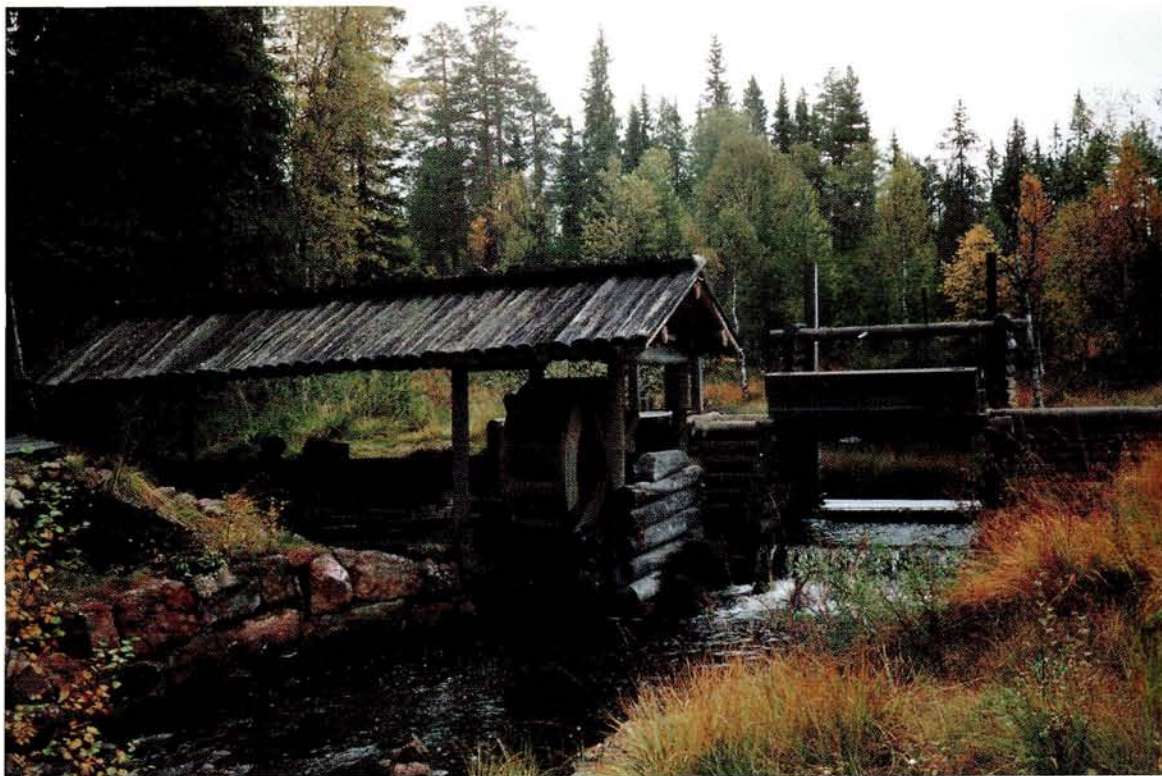
Fig. 1. Rekonstruktionsforsøg af 1700-tals blæsterovn med vandmølledrevne blæsebælge. Gryvelåreservatet, Älvdalen, Dalarna. 18. september 1991.
