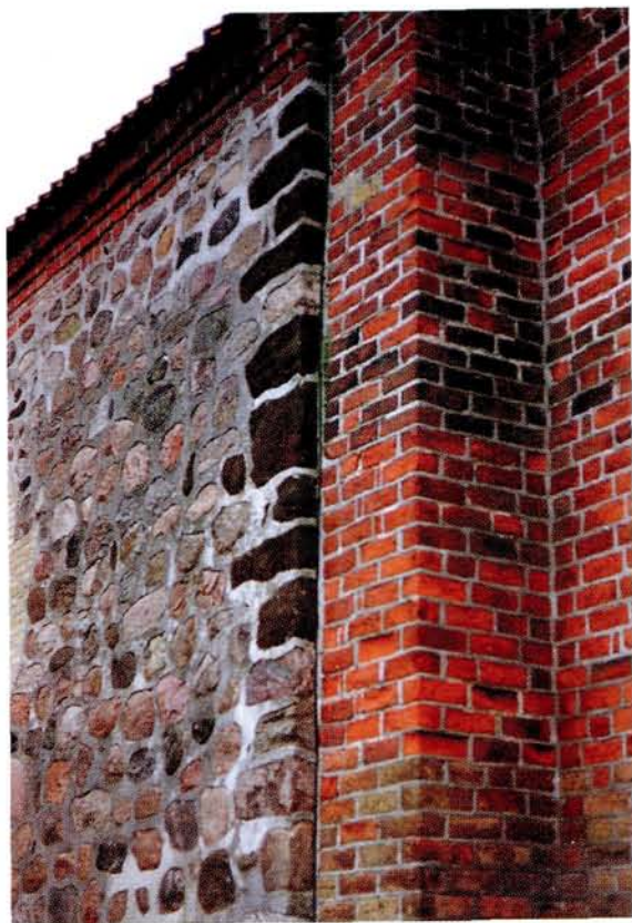
Fig. 9. Nærbillede af et hjørne på Højby kirke, Odsherred. Kvadre af myremalm og marksten, samt almindelige murensten. April 1992.
