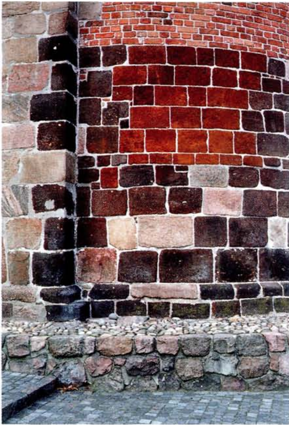
Fig. 8. St. Jacobs kirke i Varde. Nærbillede af apsis. Der er anvendt kvadre af marksten og af myremalm, og højere oppe er man fortsat med munkesten. Myremalmen stammer fra et af de talrige lejer i omegnen af Varde. August 1993.
