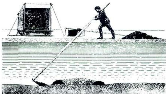
Fig. 15. Optagning af søalm fra isen om vinteren. Søalmen ligger som isolerede kager i et indtil 30 cm tykt bundlag. På isen ses et skjul, en kælk, et sold og en bunke, der er klar til at blive slædet i land. Gammelt træsnit fra Småland.
